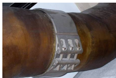
套管式橡膠密封接頭
