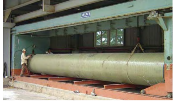
42" 海水管靜水壓測試情形
