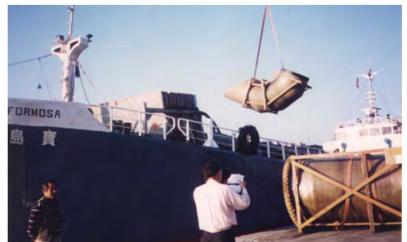
海口電廠 1800m/m 海水循環管裝船
